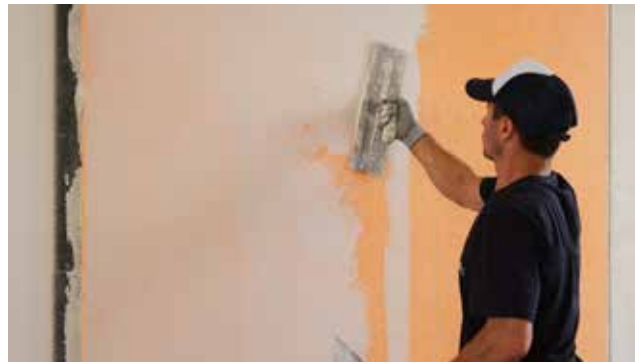
15 Applicare le altre mani di rasatura (sono consigliate almeno 2 mani ) di finitura.
