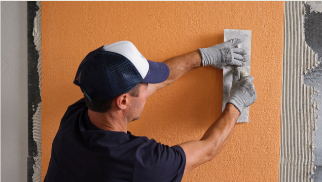
12 Schiacciare per eliminare le bolle d'aria
