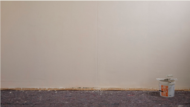
16 Il muro alla fine dell'applicazione delle 2 mani di rasatura
