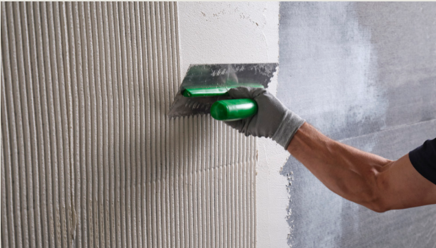
10 Utilizzare la spatola dentata per favorire l'adesione della membrana
