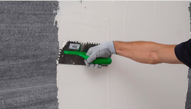
9 Applicare l'adesivo e sulla parete con una spatola dentata
