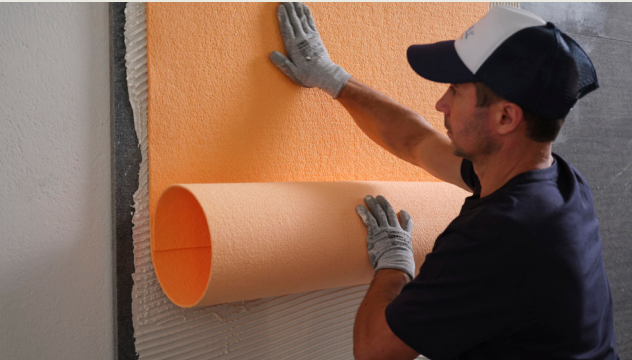
11 Stendere e posizionare il telo Isobell
