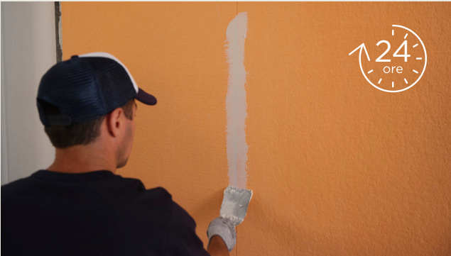
14 Stuccare i teli Isobell affiancati. Lasciare asciugare per almeno 24 ore
