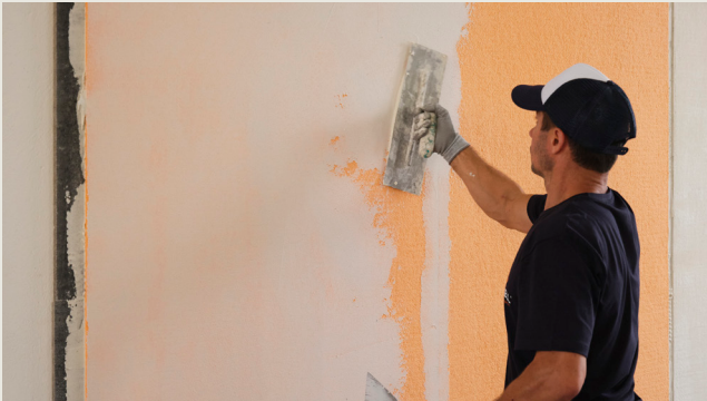
15 Applicare le altri mani di rasatura (sono consigliate almeno 2 mani ) di finitura.
